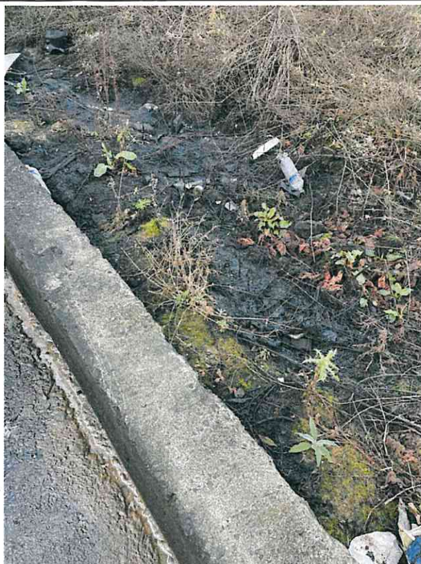
PHOTO 5 – Présence de déchets et hydrocarbure au-delà du dispositif de rétention
