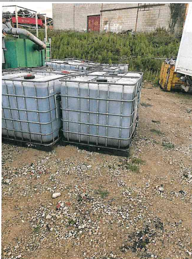
PHOTO 3 – Cuves GRV contenant effluents aqueux sans dispositif de rétention.
